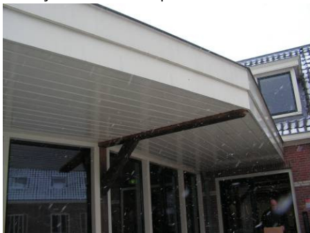
Dak van te slopen tussengebouw
