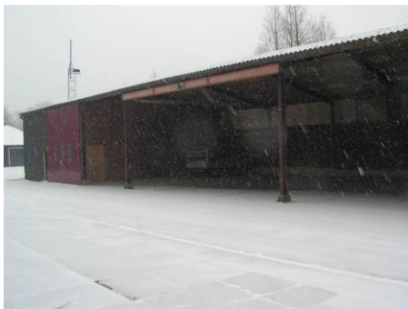
Voorzijde van de te slopen loods
