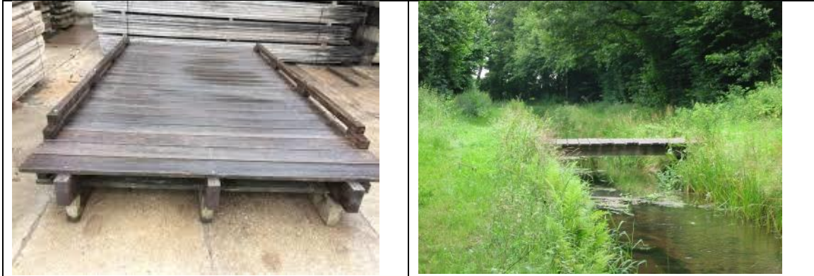
figuur 8. Voorbeeld draglineschotten
