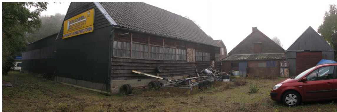
Achterzijde planlocatie, gezien vanaf de Vecht.
