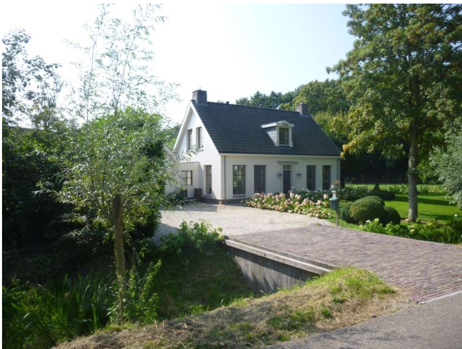
Bij dit pand is een tra- ditionele vorm vertaald in hout en zijn zesruits- vensters aangebracht als verwijzing naar het historisch karakter. Kapvorm en dakpan- nen spreken een eigen taal.
