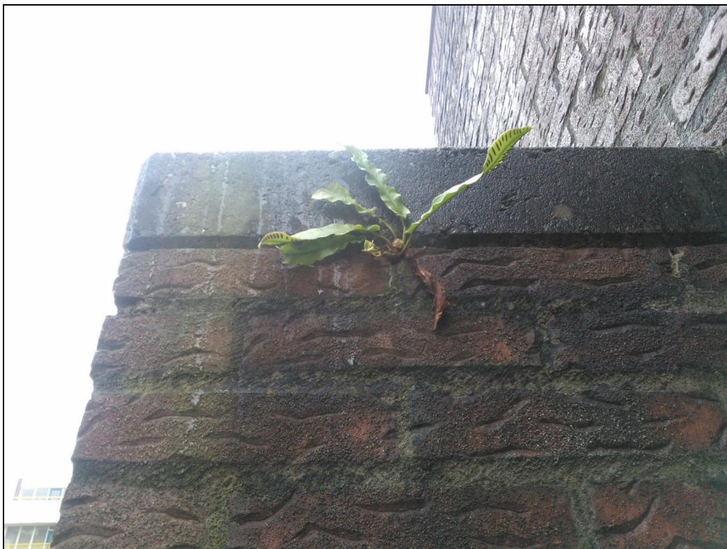
Figuur 4.2: Tongvaren op de gevel van het te slopen pand.
