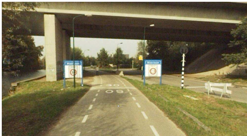
Figuur 2.2: Oostwaard ter hoogte van viaduct bij NRU Zuilense Ring
