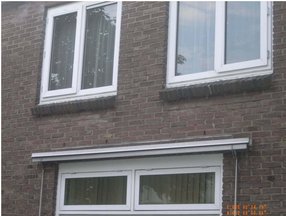
Figuur 12: stootvoegen boven het raam in de Nassaustraat.
