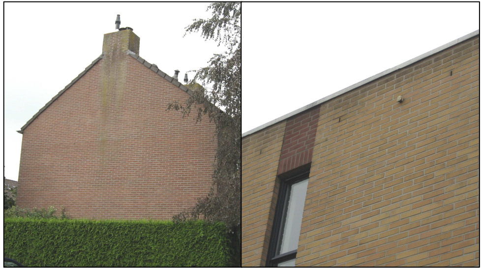
Figuur 4: Voorbeelden van gebouwen in Kockengen die verblijfplaatsen van vleermuizen kunnen herbergen. Links: spouwmuur toegankelijk via dakpannen. Rechts: spouwmuur toegankelijk via open stootvoegen.
