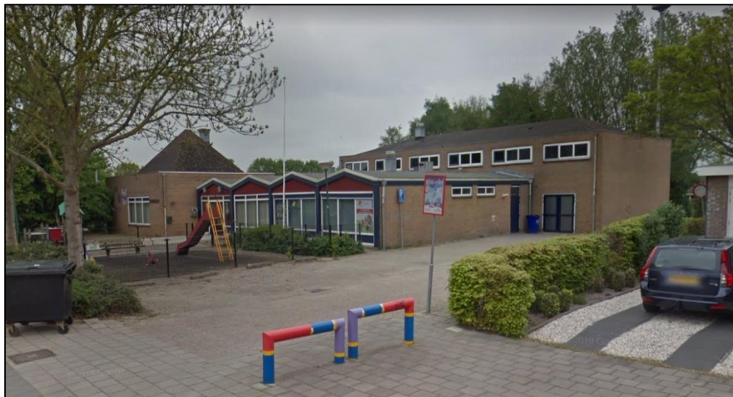
Huidige situatie ter plaatse van het dorpshuis (Bron: Google Maps).
