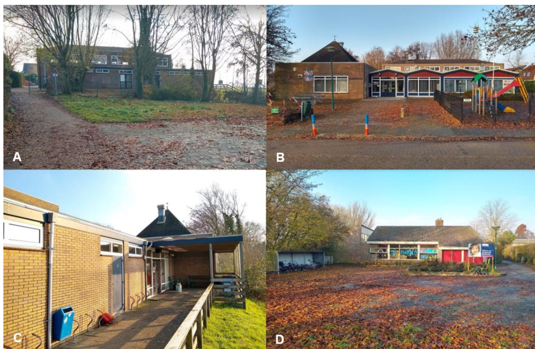
Figuur 2.2: Impressie van de gebouwen in het plangebied. A=Gymzaal, B=Schoolplein en dorpshuis; C=ingang gymzaal; D= schoolgebouw.
