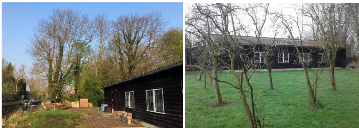
Figuur 5. Huidige loods op het plangebied. Rechts de zuidelijke kadezijde en links de noordgevel.
