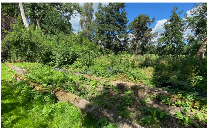
Gemetselde restanten van de broeibakken.
