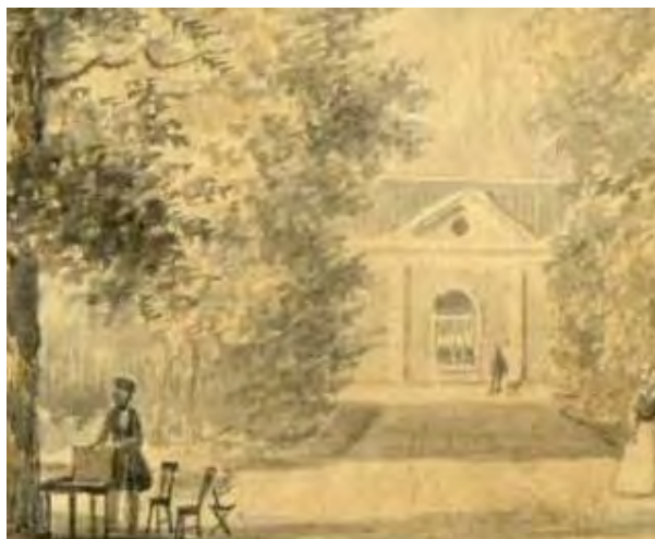
Koetshuis Hunthum te Nieuwersluis, tekening Lutgers ca 1850, HUA. Het koetshuis was een langgerekt gebouw, bestaande uit één laag met een schilddak. De middenpartij werd geaccentueerd door een driehoekig fronton met pilasters.
