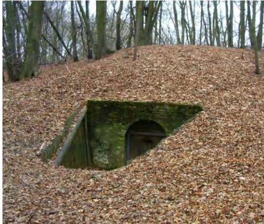
Referentie plint: ijskelder Doorwerth
