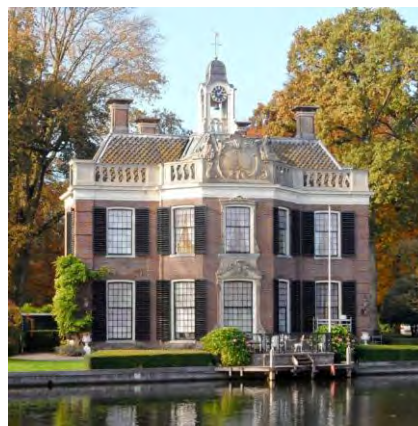
Rupelmonde te Nieuwersluis. Referentie koepelkamer Vechtzijde
