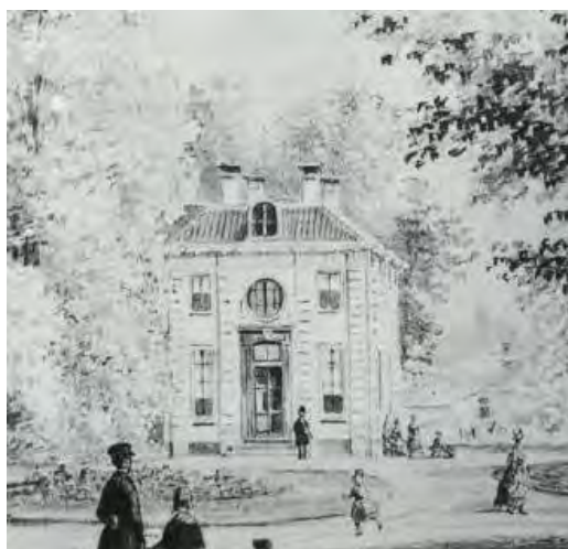
Hunthum te Nieuwersluis, Lutgers, ca. 1850. HUA. Het huis was een witgepleisterd huis met geblokte pilasters en empire ramen, voorzien van een omlappend schilddak. De begane grondvloer lag verhoogd ten opzichte van het maaiveld in het park (ca. 80-100 cm)
