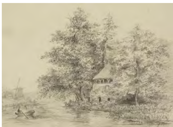
tekening Follie Hunthum, 1840, HUA. De follie bestond uit een kloeke gemetselde onderbouw met erboven een koepel. De onderbouw, waarin vermoedelijk een ijskelder was opgenomen, was rustiek en had een uiterlijk van natuursteenblokken of een blokverdeling in cementstucwerk. De koepel was uitgevoerd in een houtskelet en was gedekt met een rieten dak.
