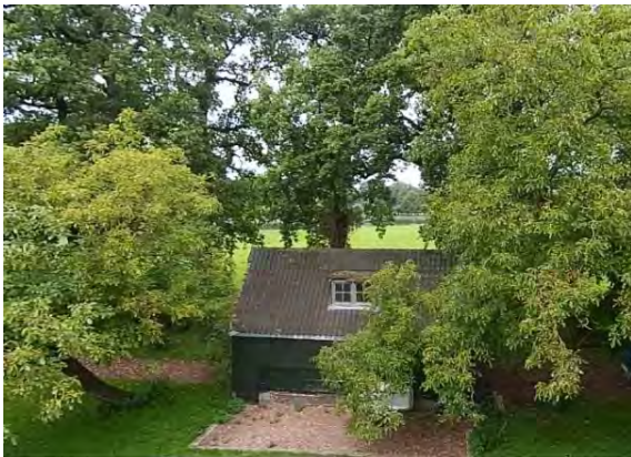
Foto van de huidige situatie, gezien vanuit het zuiden. Het bijgebouw kende een aanbouw aan de zuidzijde. Op de voorgrond is de fundering van een recent gesloopte aanbouw zichtbaar.
