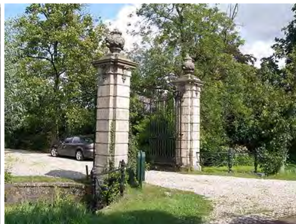
hek Otterspoor. Referentie voor het herstel van de natuurstenen hekpijlers.
