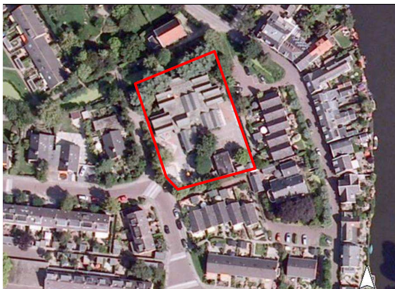
Figuur 3.1 Ligging van plangebied (kader) en directe omgeving met rechts de Vecht
