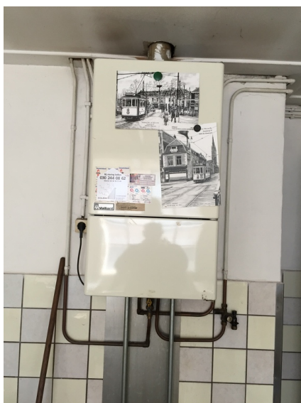
CV kantoor gebouw 7
