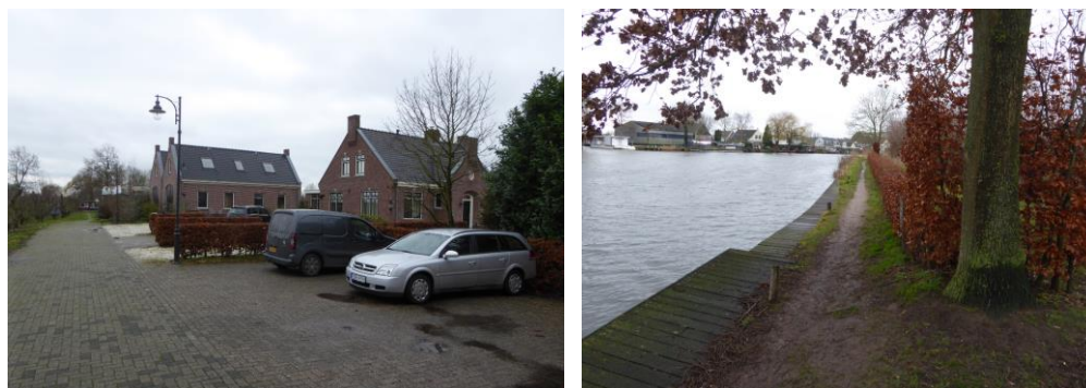
Woning en bedrijfsgebouw (links); de Vecht en jaagpad (rechts)
