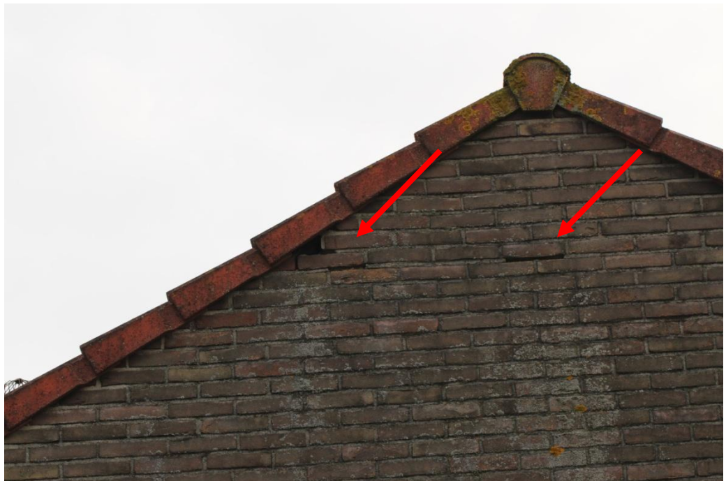
Foto 5: openingen in de muur bieden mogelijk toegang tot een geschikte ruimte hierachter.
