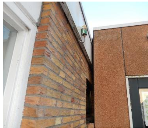
Foto 6: Ruimte tussen schoolgebouw en aangebouwd deel
