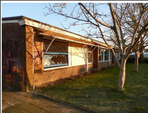
Foto 1: Voorkant school gebouw met beplanting en grasveld
