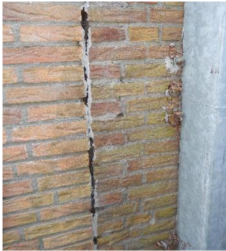
Foto 5: Ruimte in muur (dilatatievoeg) aan achterzijde gebouw
