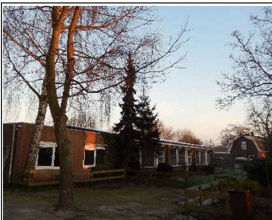
Foto 1: Voorkant school gebouw met beplanting en grasveld
