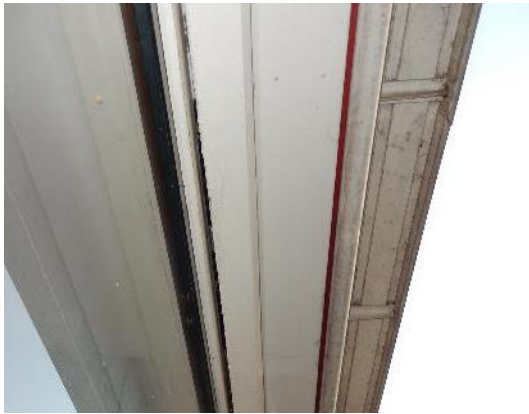
Foto 5: Ruimtes langs kozijnen
