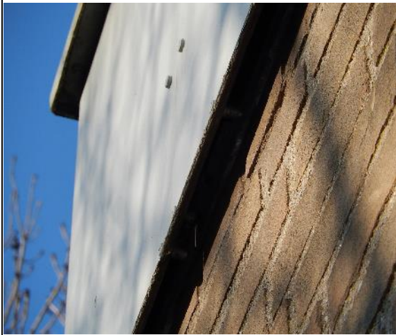
Foto 5: Ruimte achter daklijst
