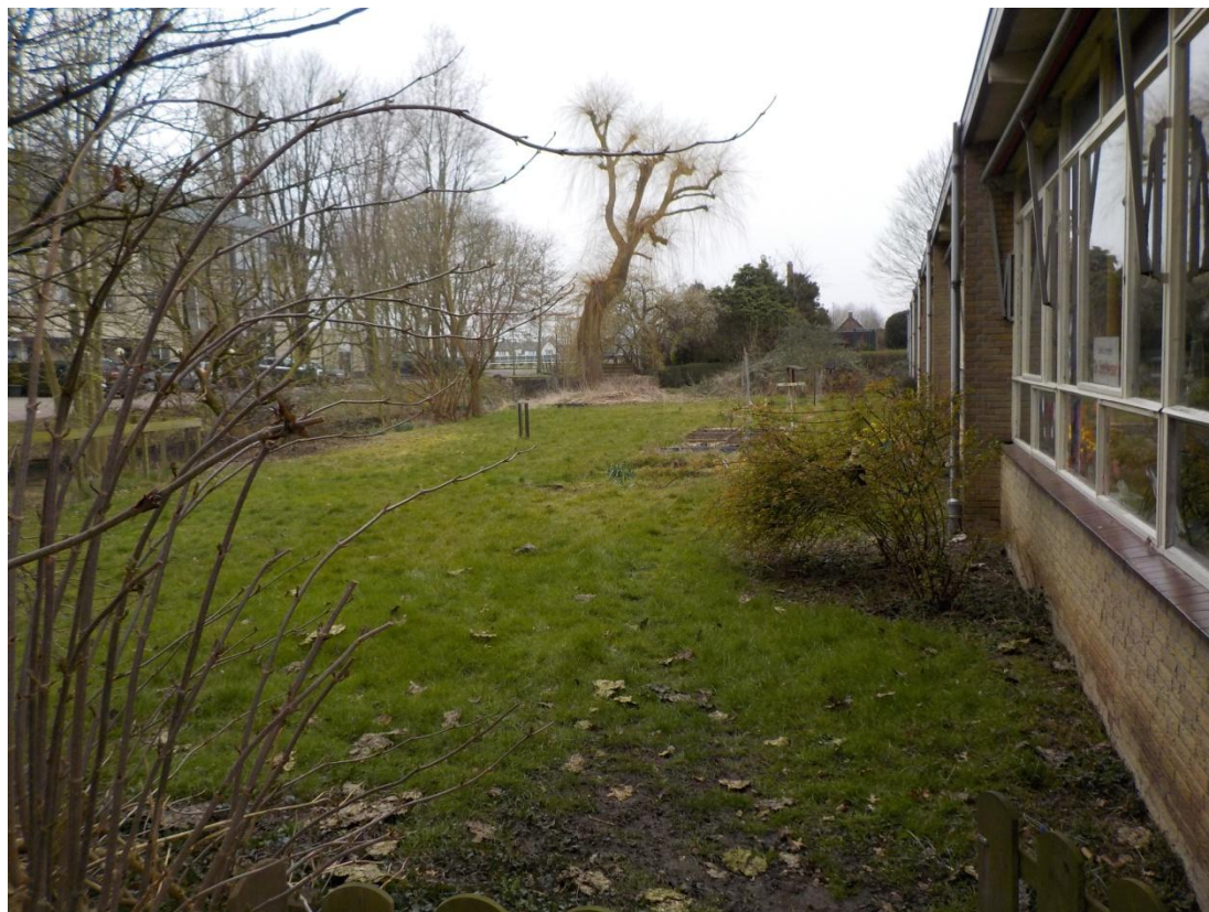
Afbeelding 18: Foto van de achterzijde van het voormalige schoolgebouw. De foto is genomen vanuit het oosten richting het westen.
