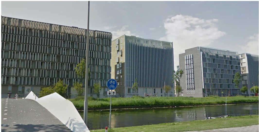
Afbeelding 4.10 Willem Augustinstraat Amsterdam, lamellen/coulissen zorgen voor voldoende afscherming
