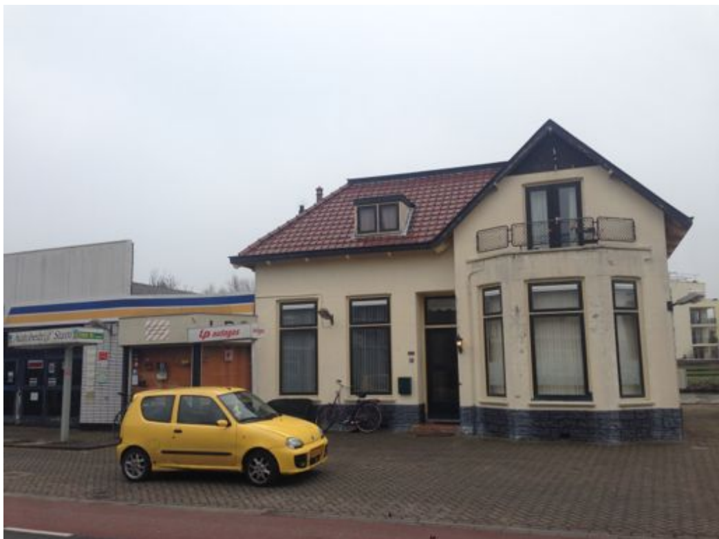
Figuur 2 De voormalige werkplaats en schuur (rechts, niet op de foto) doet dienst als opslag. De woning wordt bewoond. Alle opstallen verkeren in achterstallige staat van onderhoud.
