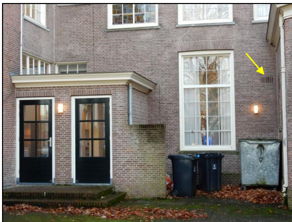
Figuur 12. Ventilatieopening in landhuis.
