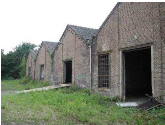
Figuur 7: In de zuidwesthoek van het gebied staat een oud vervallen magazijn.
