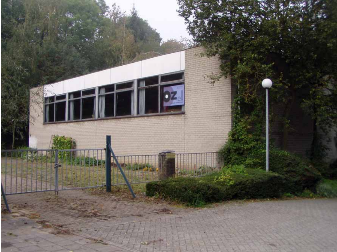
Leegstaand gebouw tussen Rijksweg 14 en 16
