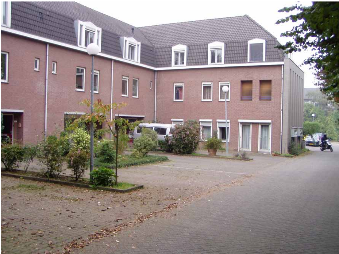
Voorzijde woonhuizen Rijksweg 14 / parkeerterrein
