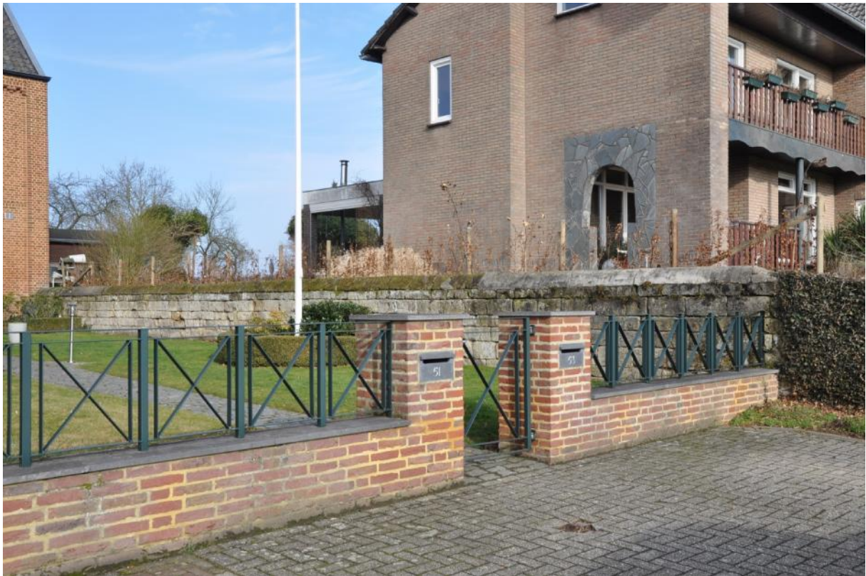
De mergelmuur gezien vanaf de Burgemeester Beckersweg
