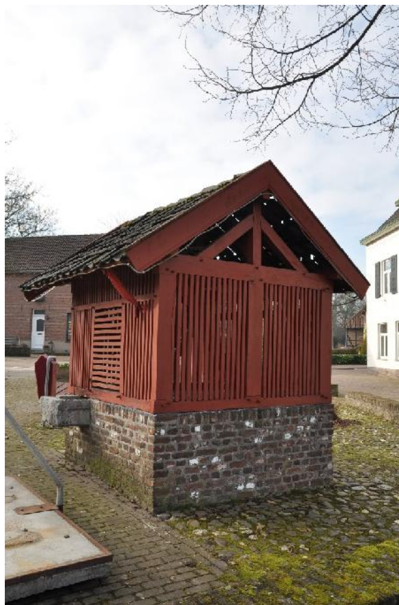
Puthuisje vanuit Duivenstraat gezien
