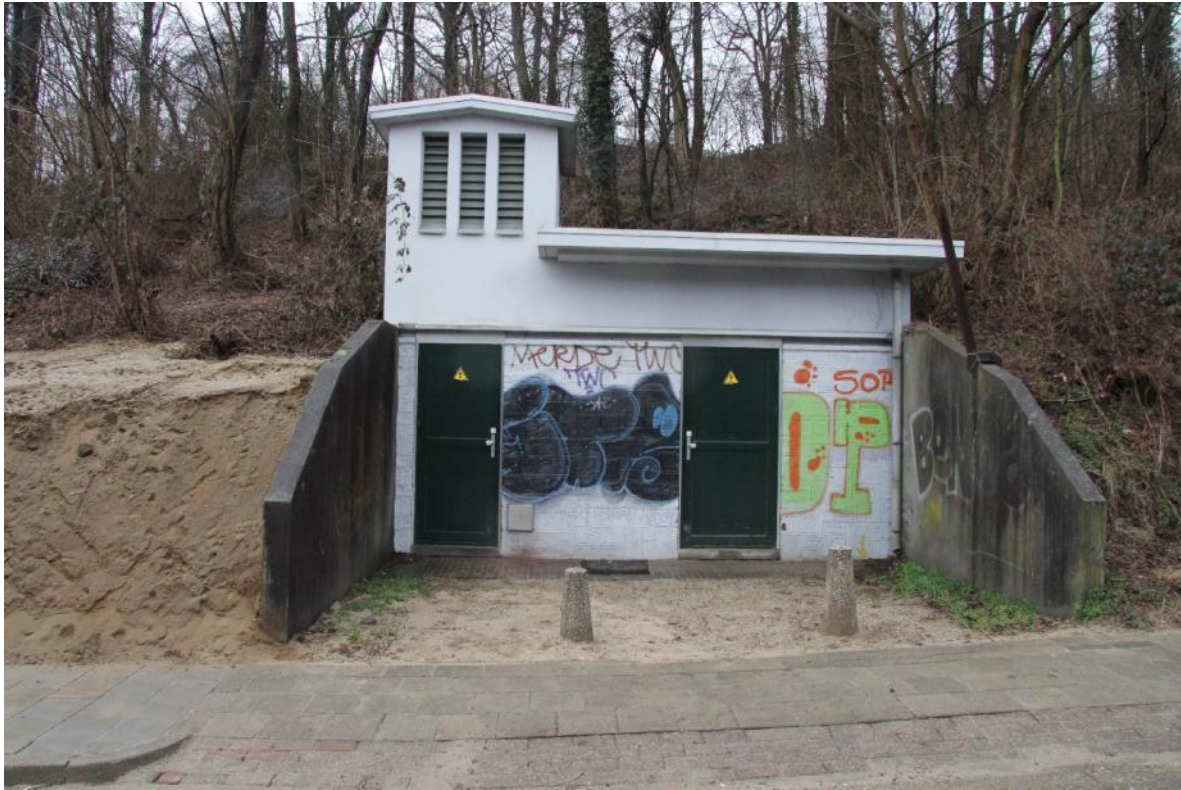
Het transformatorhuisje vanaf de Rijksweg gezien
