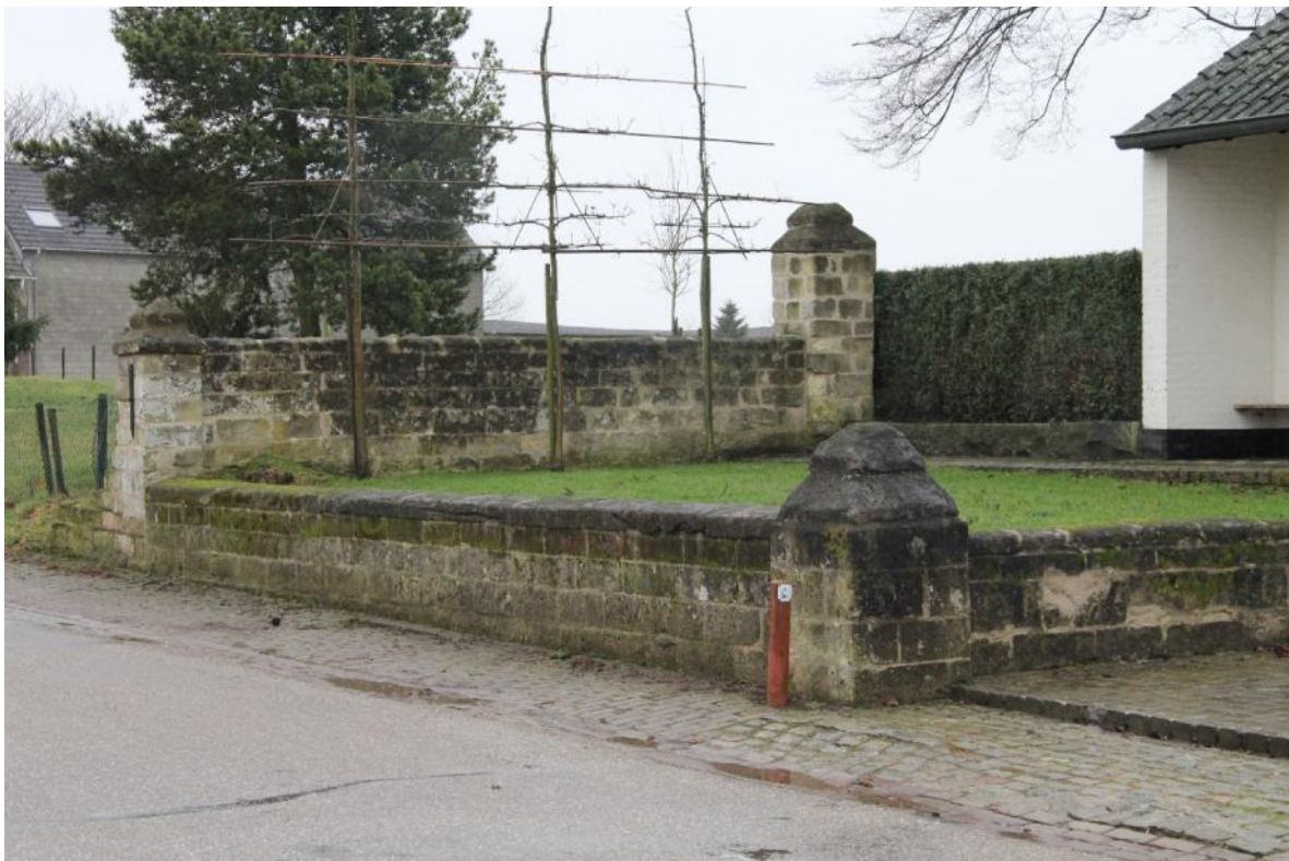
Muurwerk met pijlers oostelijke zijde
