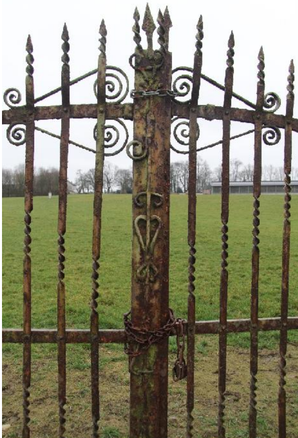
Detail van hekwerk
