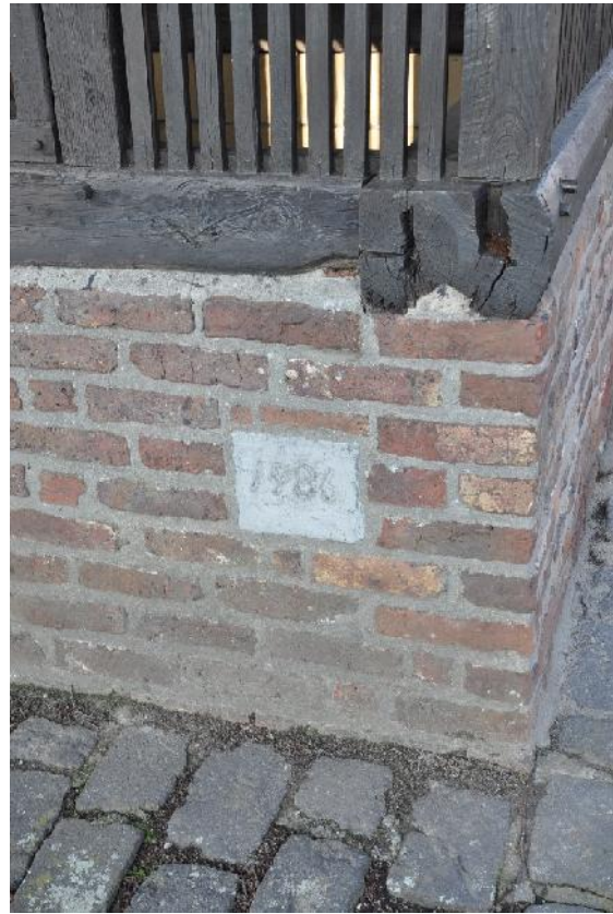
Detail: steen met jaartal restauratie
