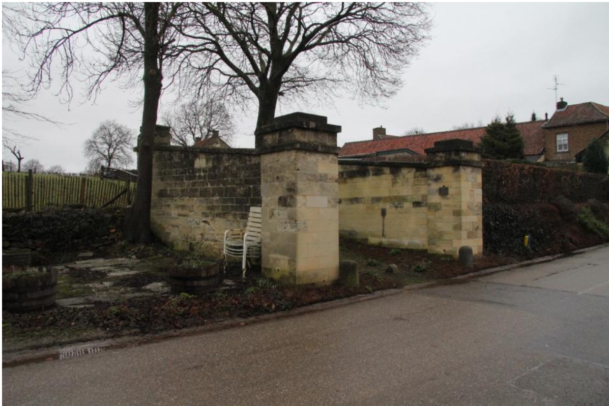
De pijlers met keermuren vanaf straatzijde
