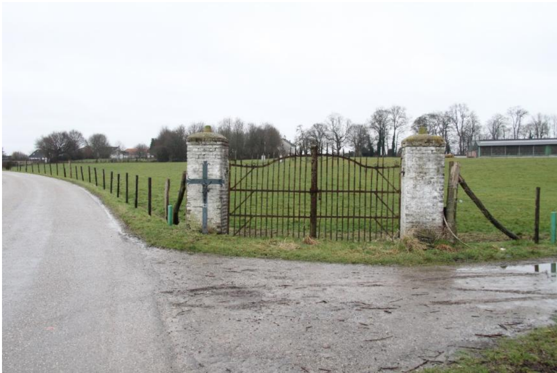
Het noordelijke paar pijlers met hekwerk gezien vanuit de Franse Steeg
