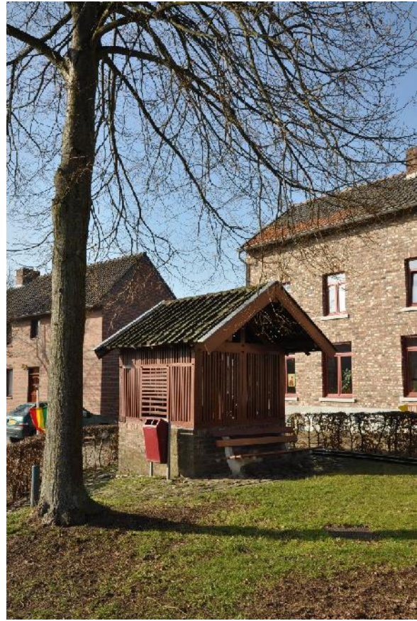
De put gezien vanuit het noorden
