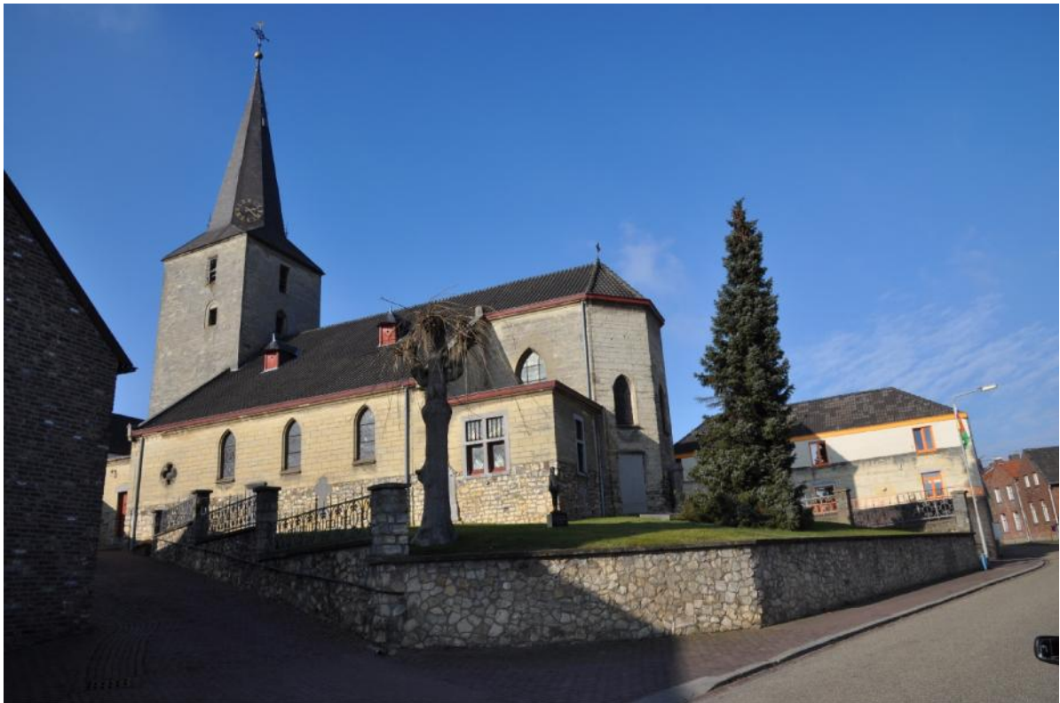
De keermuur in zijn ruimtelijke context
