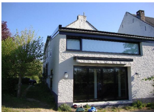
Zicht op de aanbouw bij de woning aan de zuidzijde
