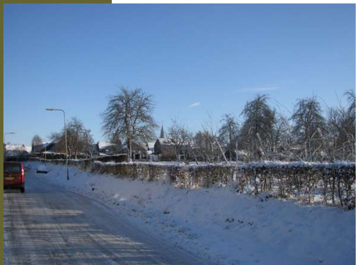
het talud wordt hoger en steiler richting de kern Eckelrade
