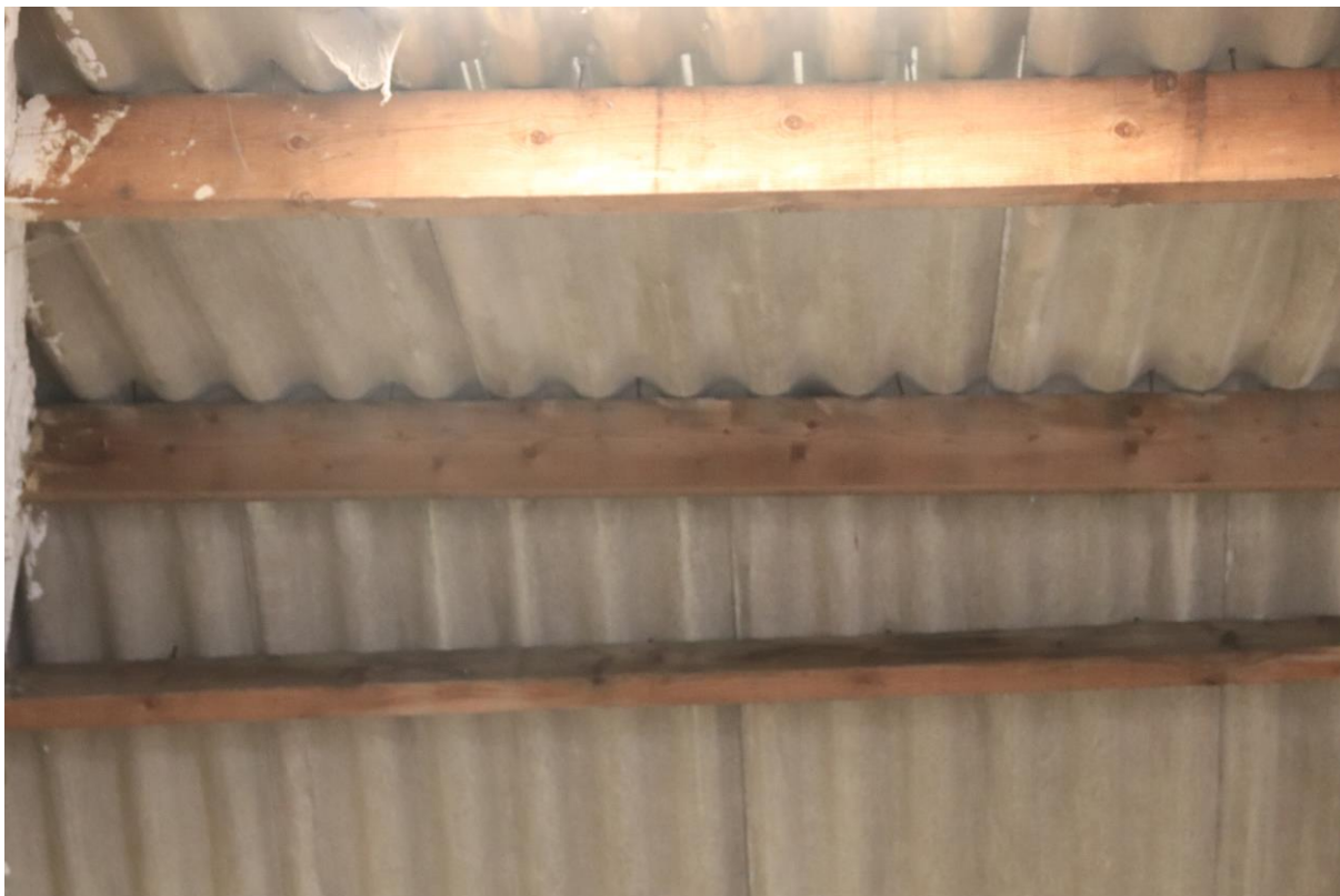
Foto 5: asbesthoudende dakplaten, vleermuizen gaan deze locatie niet als vaste rust- en verblijfplaats gebruiken, mede door het ontbreken van een optimaal en stabiel klimaat
