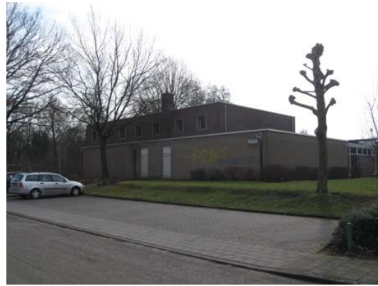
Figuur 4: De sporthal, gezien in zuidoostelijke richting.
