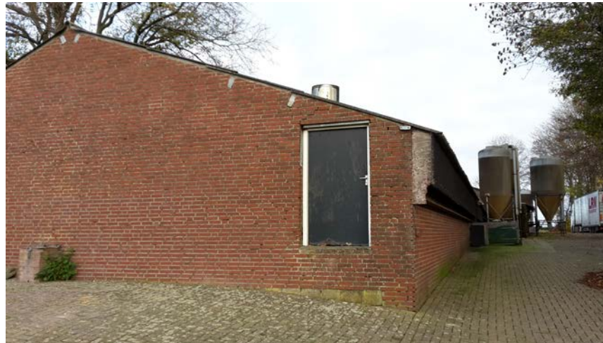
Te saneren bebouwing en erf
