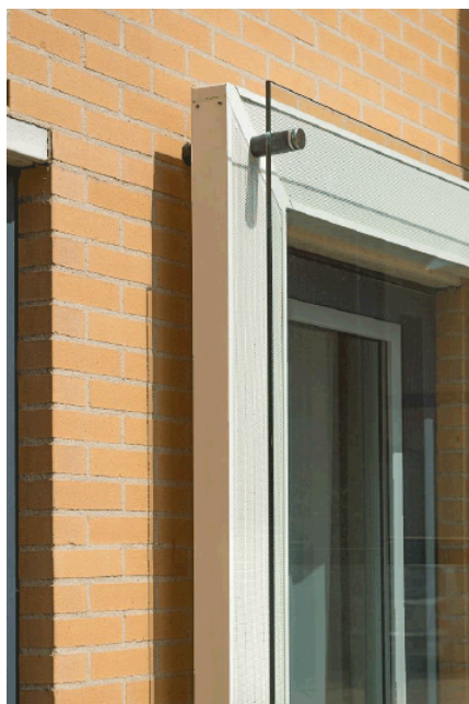
Figuur 2.10: Glazen gevelgeluidsscherm (Metaglas)
