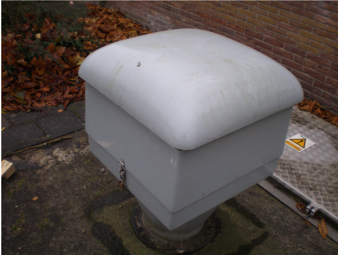
Foto 2.3: Geuremissiepunt met als reductietechniek een kaliumpermanganaat-filter
