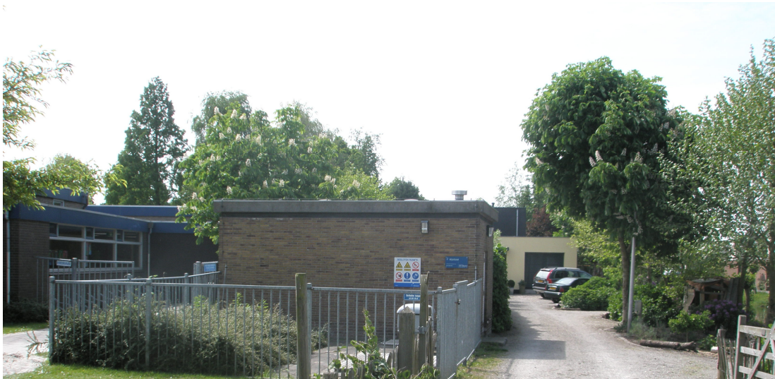
Foto 2.1: Rioolgemaal Reeuwijk West te Reeuwijk
