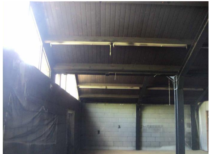
Figuur 9: dakconstructie binnenkant loods
