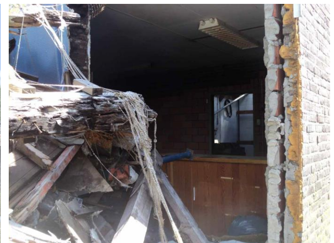
Figuur 7: Detail gebouw met open spouwmuur
