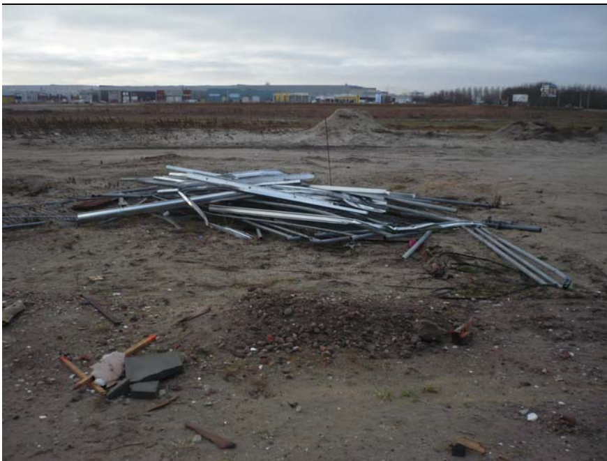
Foto 6. Bouwafval op het middendeel van het terrein
