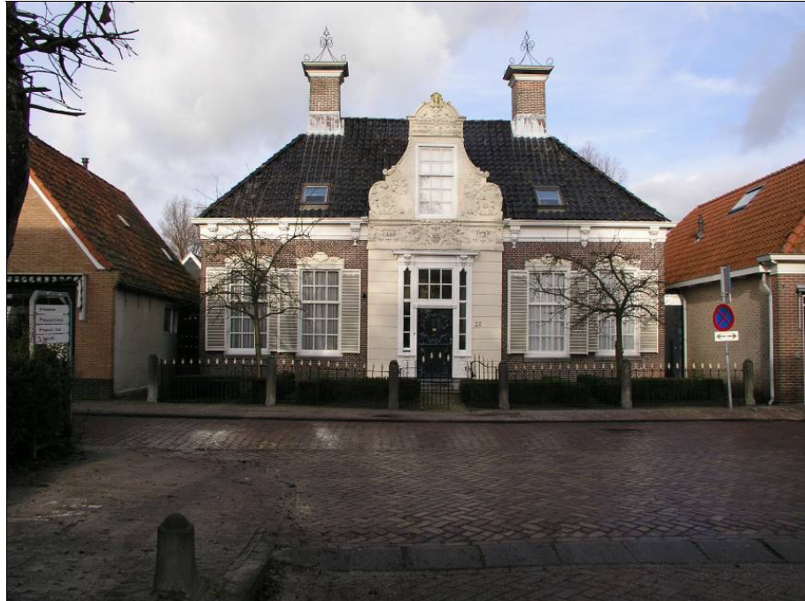
Figuur 1. Karakteristiek pand aan de Harinxmastrjitte
