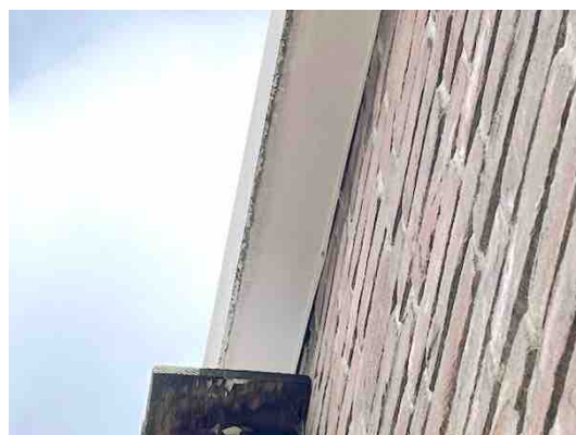
Figuur 12. Dakrand kopgevel met wisselend afstand tussen bevestigingsrand en gevel.
