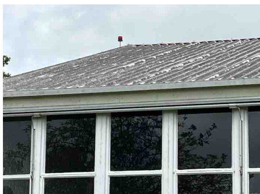
Figuur 9. Westgevel gebouw.
