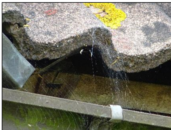
Afbeelding 3.1. Afgedichte ruimte dakpannen voorste deel. Afbeelding 3.2. Ruimte tussen dakgoot en dakpannen.
