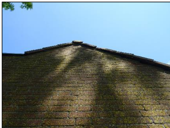
Afbeelding 3.6. Koppevel met ruimte tussen de pannen en het metselwerk.
