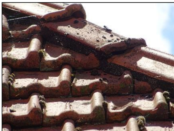
Afbeelding 3.1. Afgedichte ruimte dakpannen voorste deel. Afbeelding 3.2. Ruimte tussen dakgoot en dakpannen.
