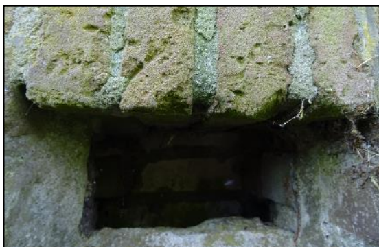
Afbeelding 3.8. Ingezoomd op ontwateringsgaten.
