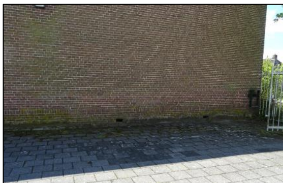
Afbeelding 3.7. Ontwateringsgaten voorste gebouw.
