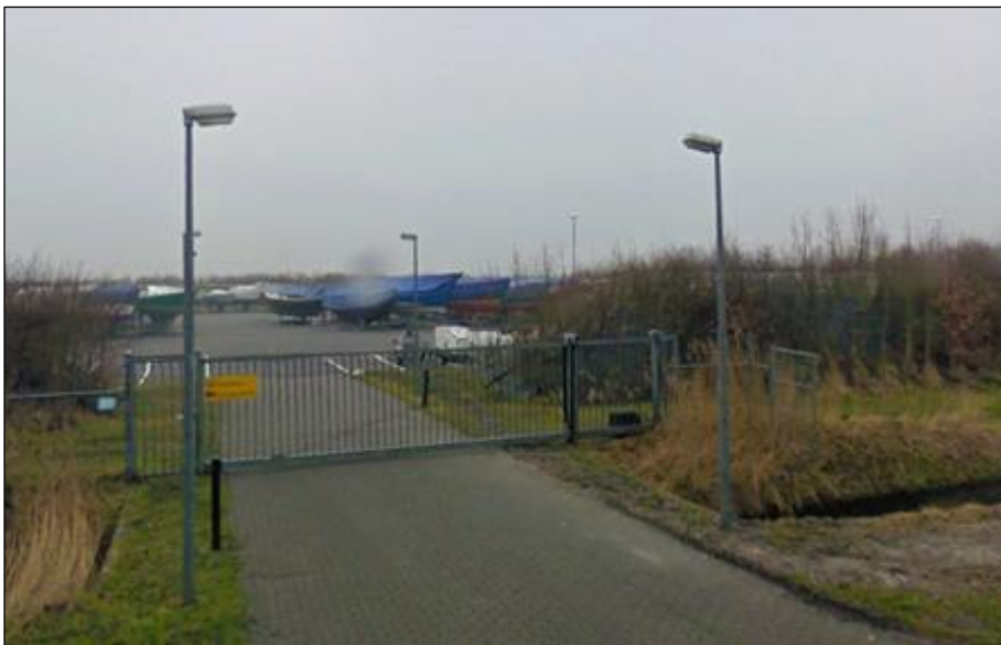
Figuur 4. Zicht op het bestaande terrein voor botenstalling
