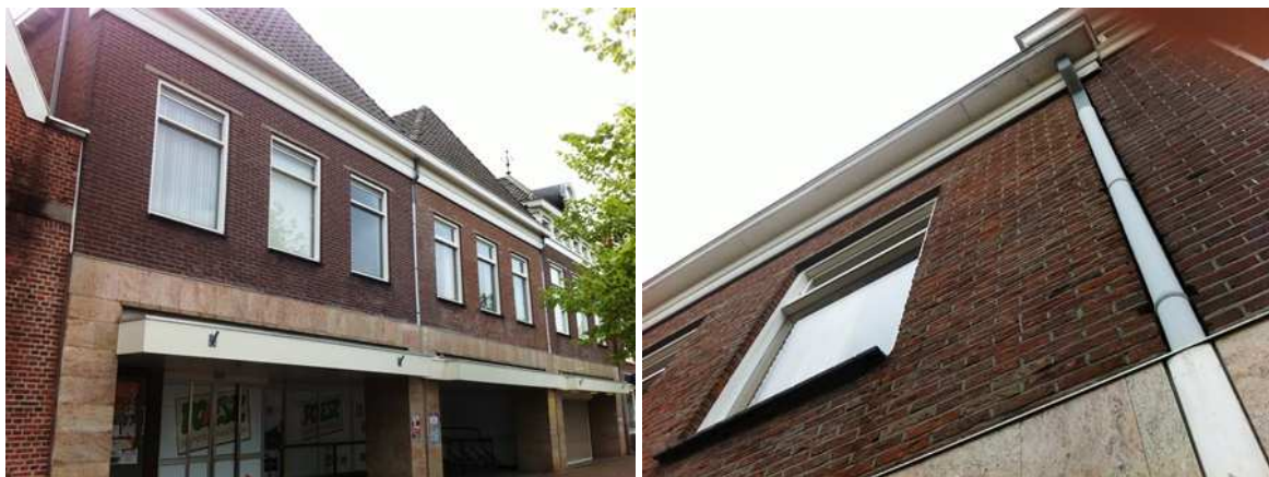
Aanzicht van de voorgevel. Op de foto is de brede witte plint aan de voorzijde van het gebouw zichtbaar. Dergelijke plinten worden soms door vleermuizen benut als verblijfplaats. Er zijn geen aanwijzingen gevonden dat vleermuizen een verblijfplaats achter deze plint bezetten.
