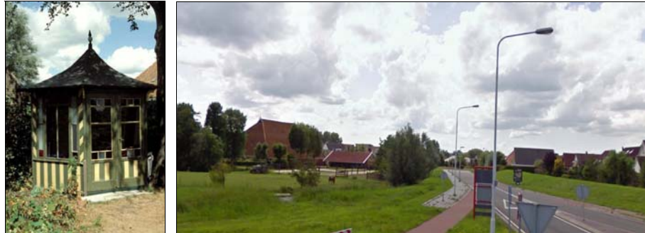
Figuur 2. Tuinhuis aan Groenedijk 2 en rijksmonument aan De Weide 1 (Bron: Google Streetview, 2009)
