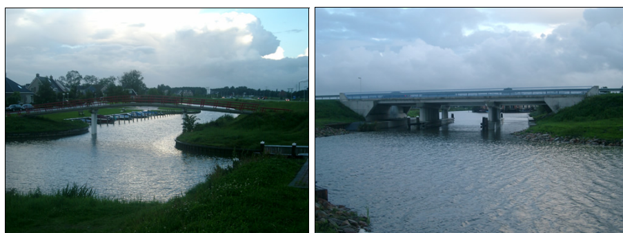
Figuur 5. Brug bij jachthaven Pasveer (Links) en Nije Griendyksterbrêge (Rechts)
