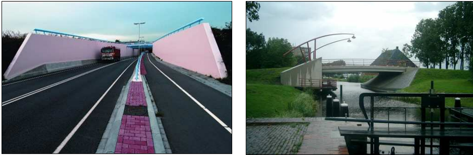
Figuur 8. Houkesleetaqueduct (links) en Dompbrêge met op de voorgrond de sluis (rechts)
