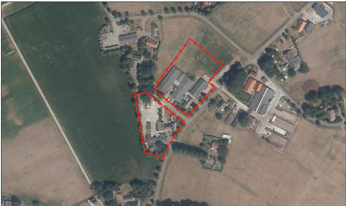
Afbeelding 2.1 Luchtfoto huidige situatie plangebied (Bron: PDOK)
