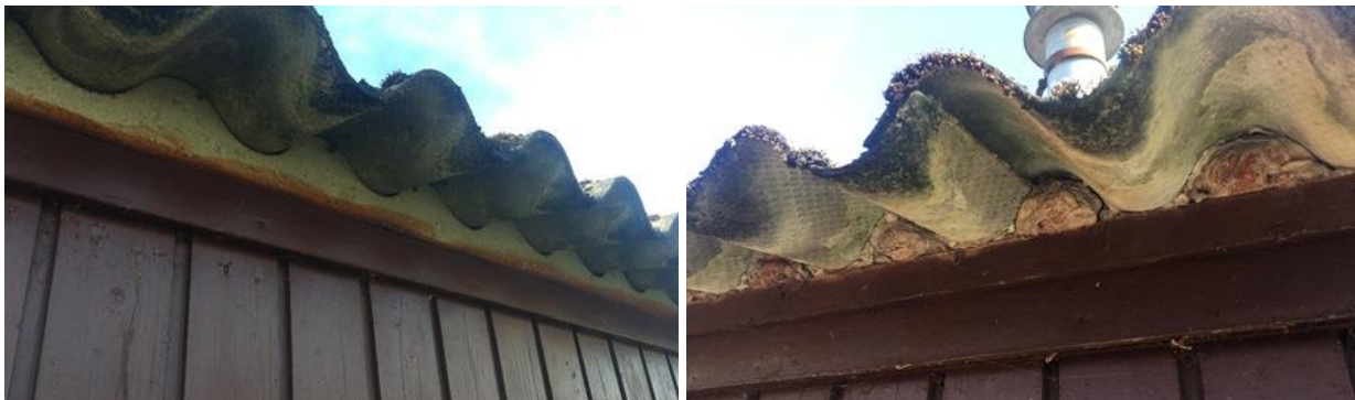
De openingen onder de golfplaten zijn afgedicht zodat vogels er niet onder kunnen kruipen.
