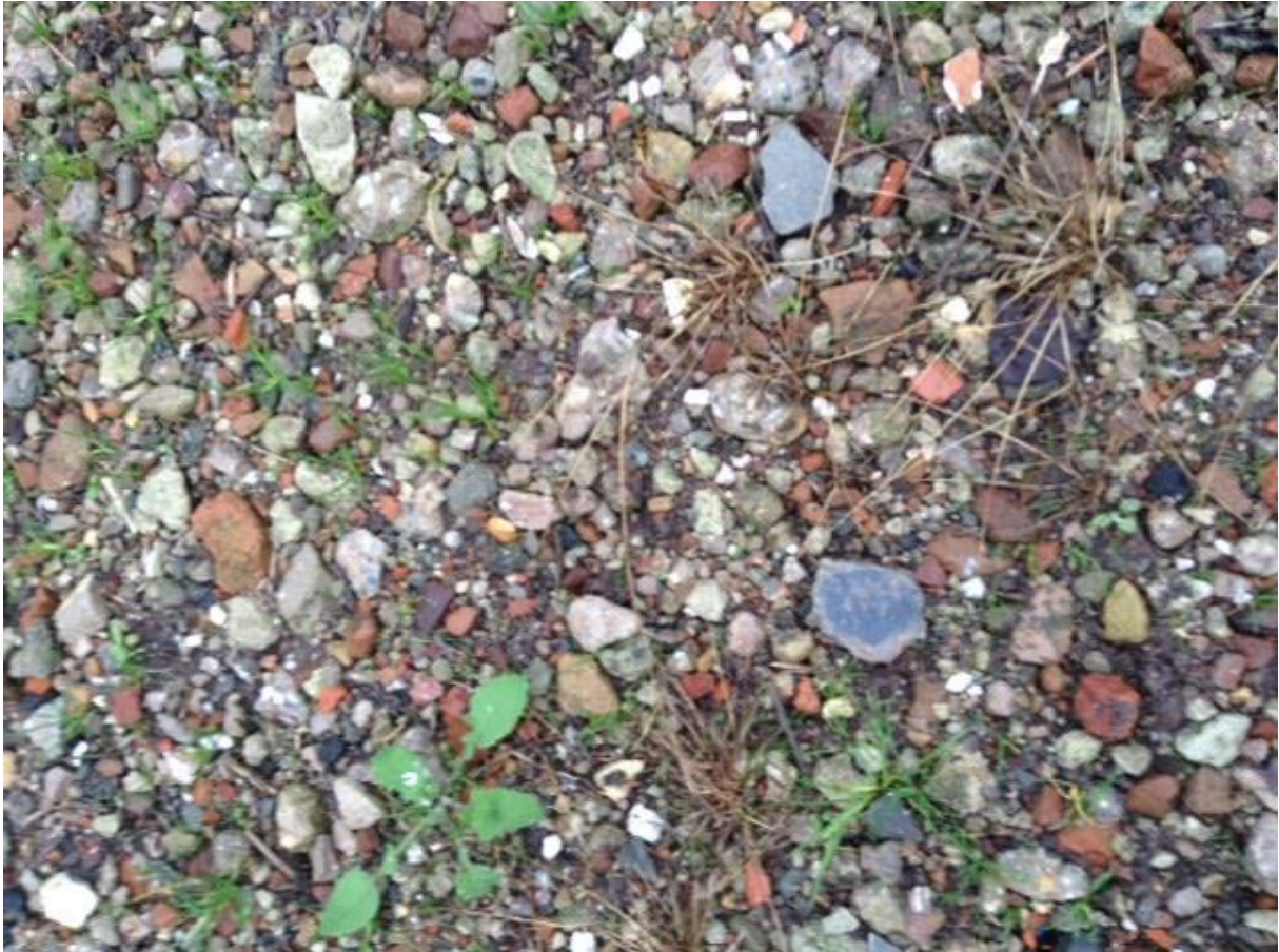
Foto 7: stukjes asbest verdacht materiaal t.p.v. aanwezige puinlaag
