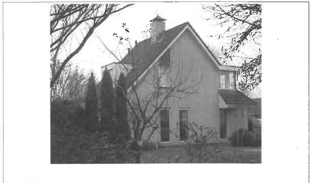
Foto 2: noord- en oostgevel
