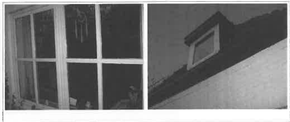
Foto's 6 en 7: ZW-gevel (woonkamer 3 en slaapkamer 2)
