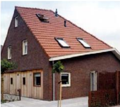
bijzondere dakvorm, kleine gevelopeningen, houten delen
