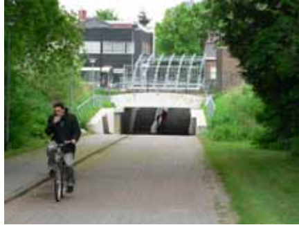
fietstunnel naar het station
