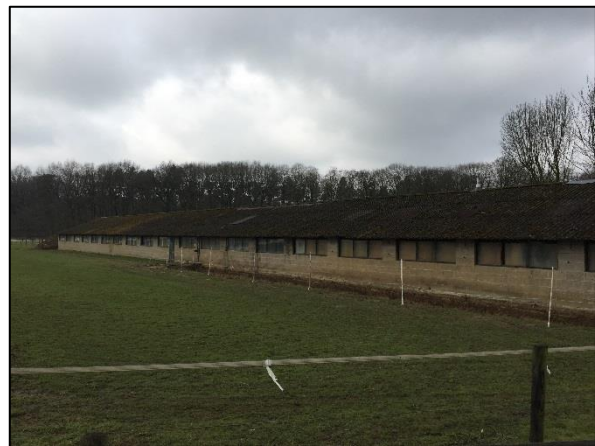
Afbeelding 3. De te slopen schuur
