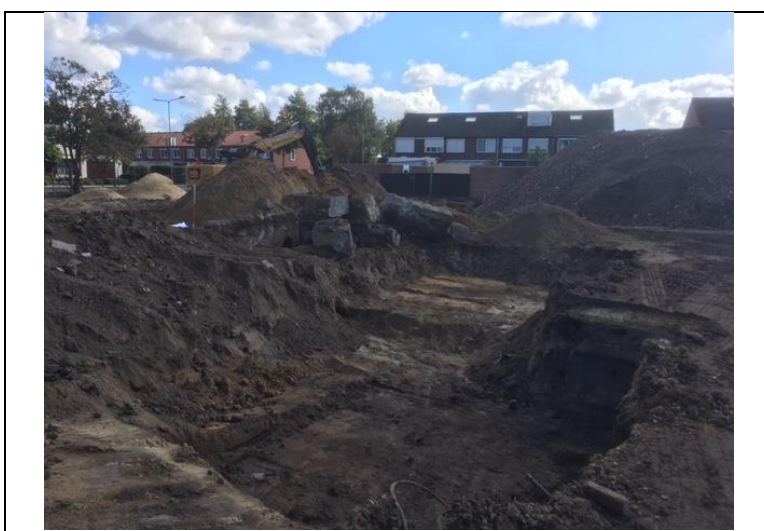
foto 2: ontgraving fase 3 (26 september 2018)
