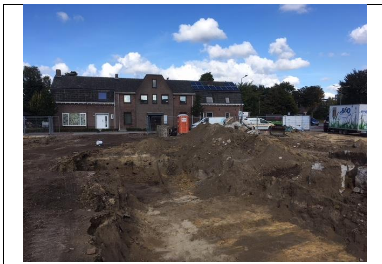
foto 4: ontgraving fase 2 (25 september 2018)
