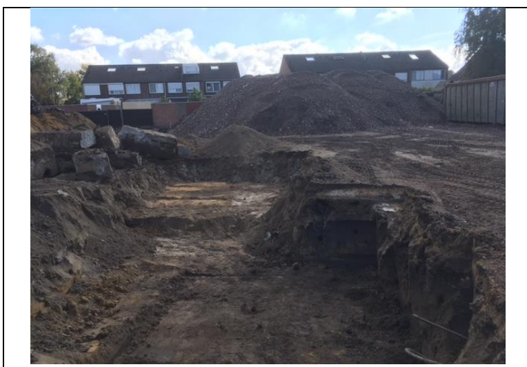
foto 3: ontgraving fase 3 (26 september 2018)
