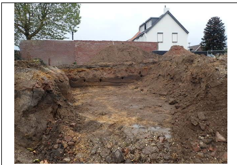
foto 1: ontgraving fase 4 (1 november 2018)
