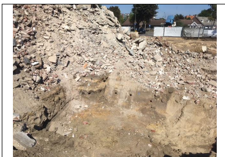
foto 6: ontgraving fase 1, B200 (14 september 2018)
