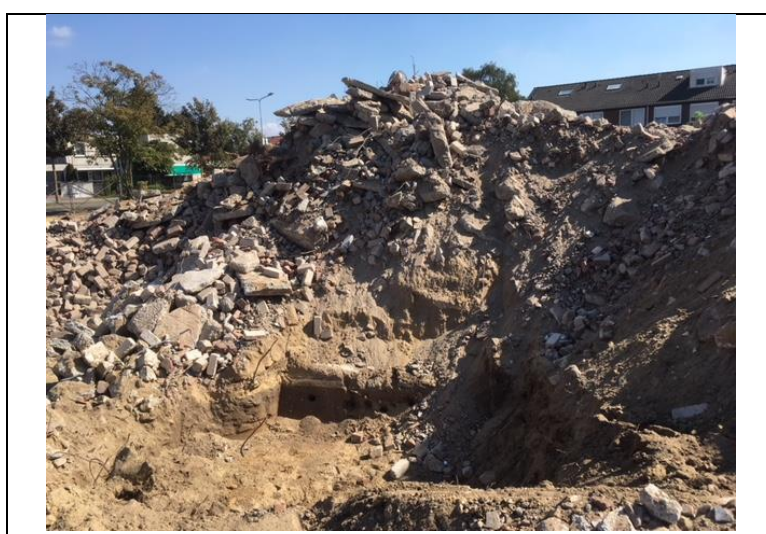
foto 5: ontgraving fase 1, B100 (14 september 2018)
